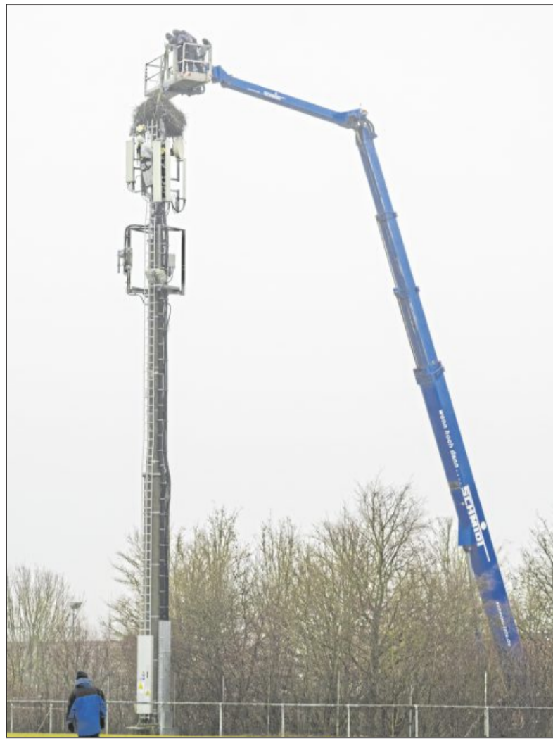
Das schwere Nest wird vom Sendemast gehievt.
